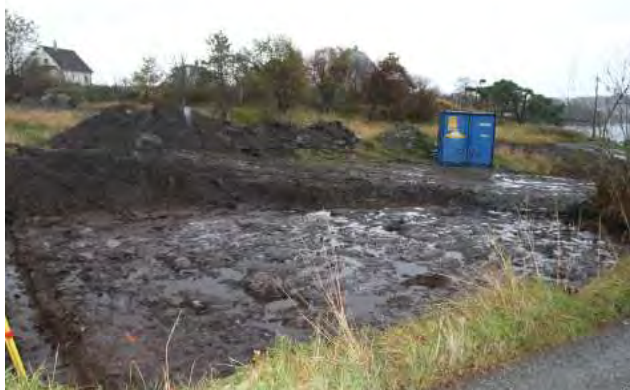
Figur 4.1.1 Oversikt over lokal 7 etter flateavdekking. Foto mot nordvest.
