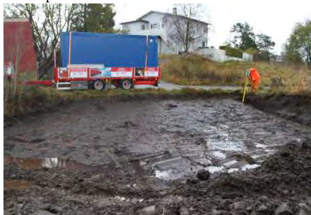
Figur 4.1.2 Oversikt over lokal 7 etter flateavdekking, etablering av koordinatsystem. Plasseringen av dräneringsschaktet till höger i bild. Foto mot sydöst.
