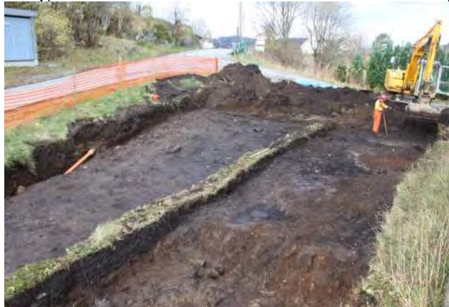
Figur 3.2.1 Pågående avbaning av lokal 8. Foto mot nordväst.
