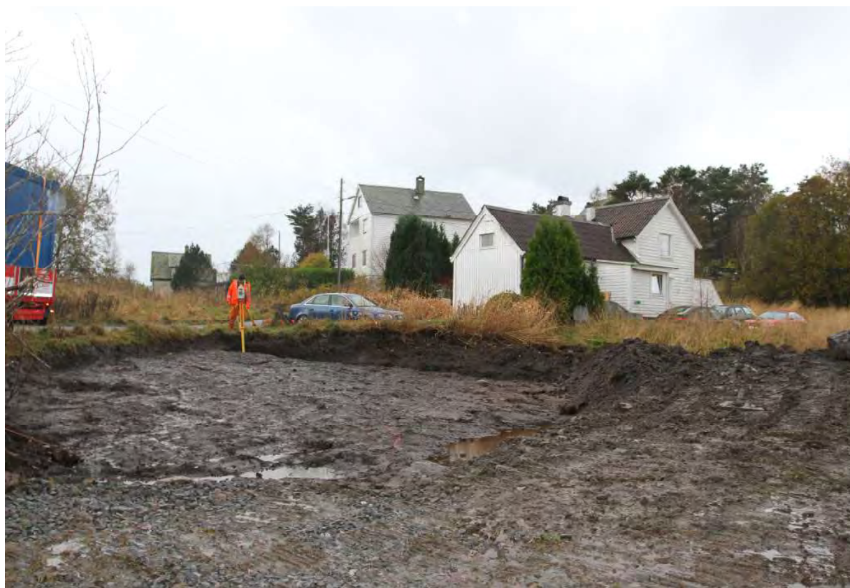
Figur 2.3.1 Översikt över lokal 7, efter avbanning. Mot söder.
