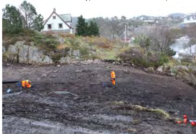
Figur 3.2.2 Avbaning utförd på lokaler 9, 9C och 9B, pågående provundersökning. Mot öster.
